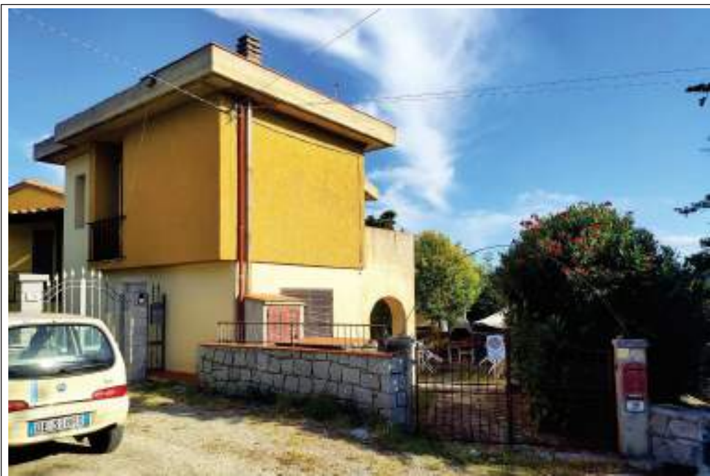
Descrizione: Foto di prospetto, da strada
