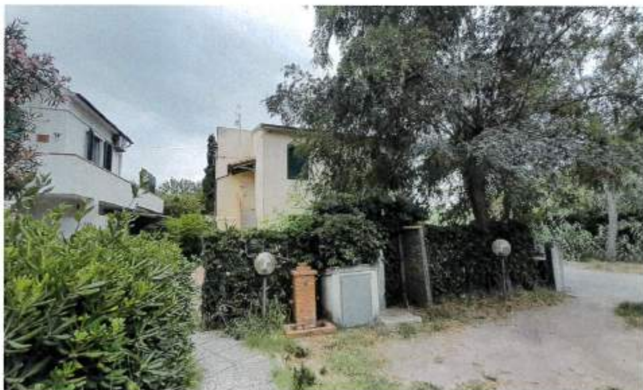
Descrizione: Prospetto lato Ovest
