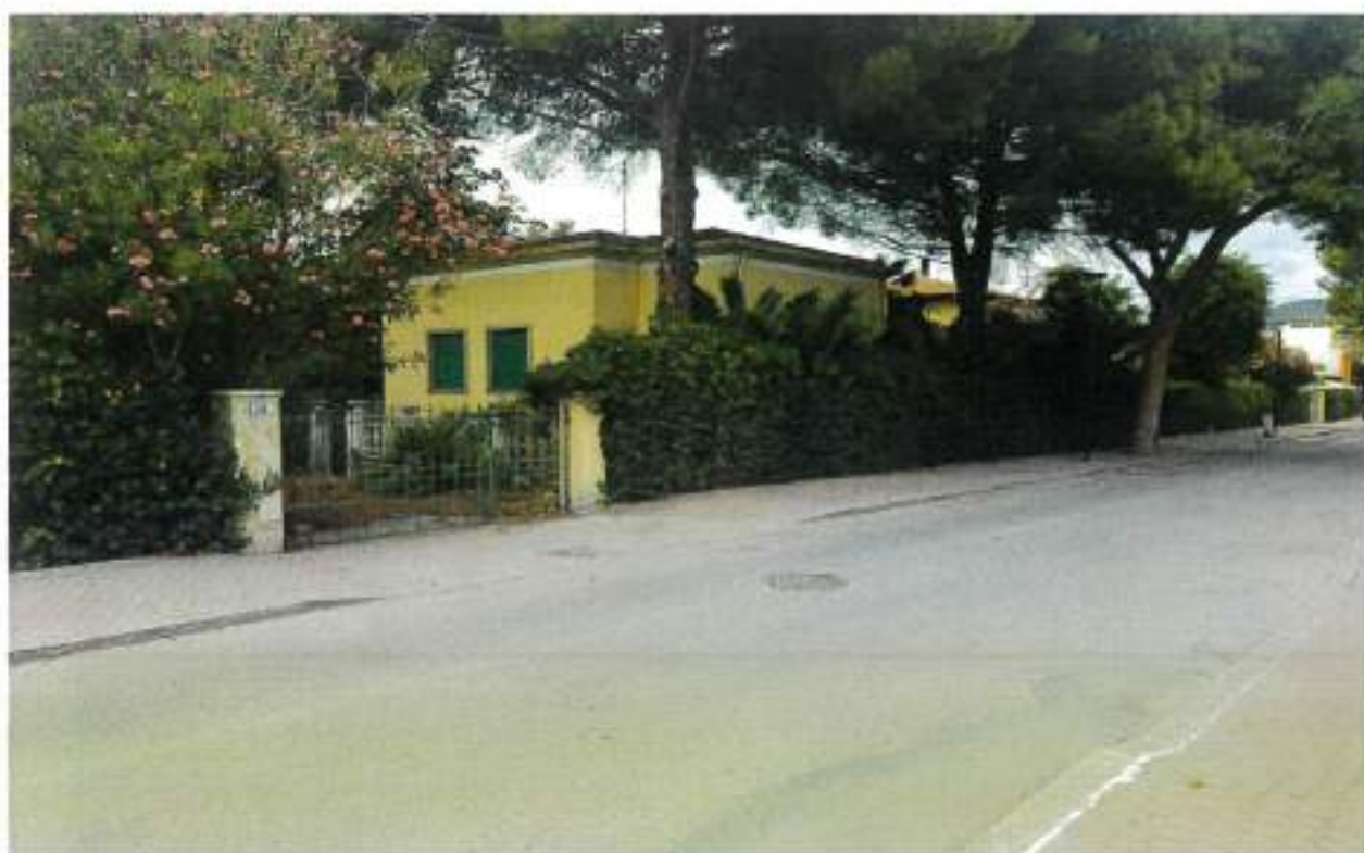
Descrizione: - Vista lato NORD - OVEST
