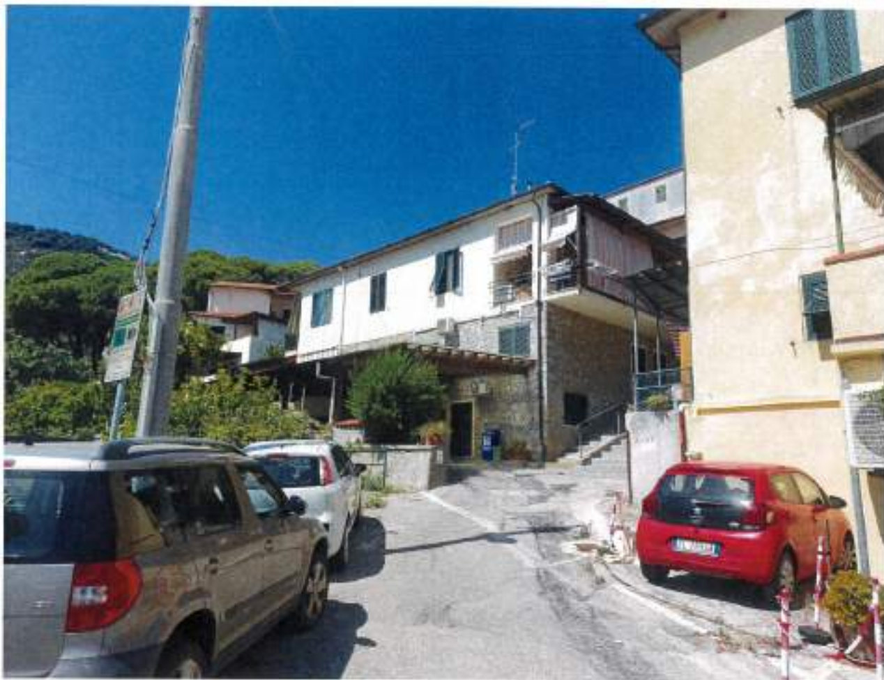
Descrizione: vista prospetti lato Sud ed Est, è evidente la porzione di edificio a facciavista
