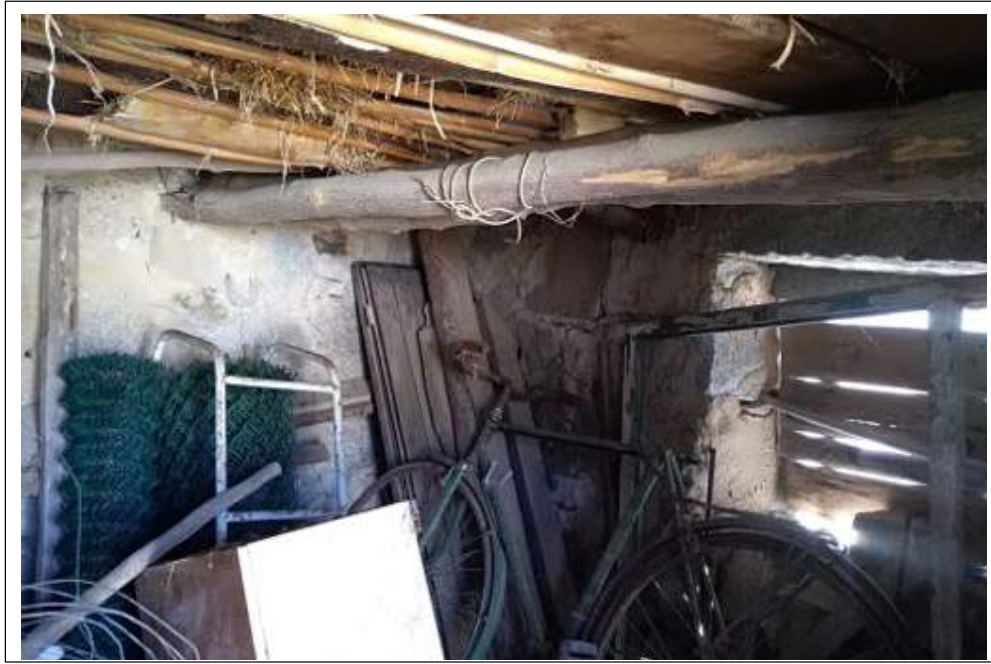
Descrizione: punto di ripresa interno;
