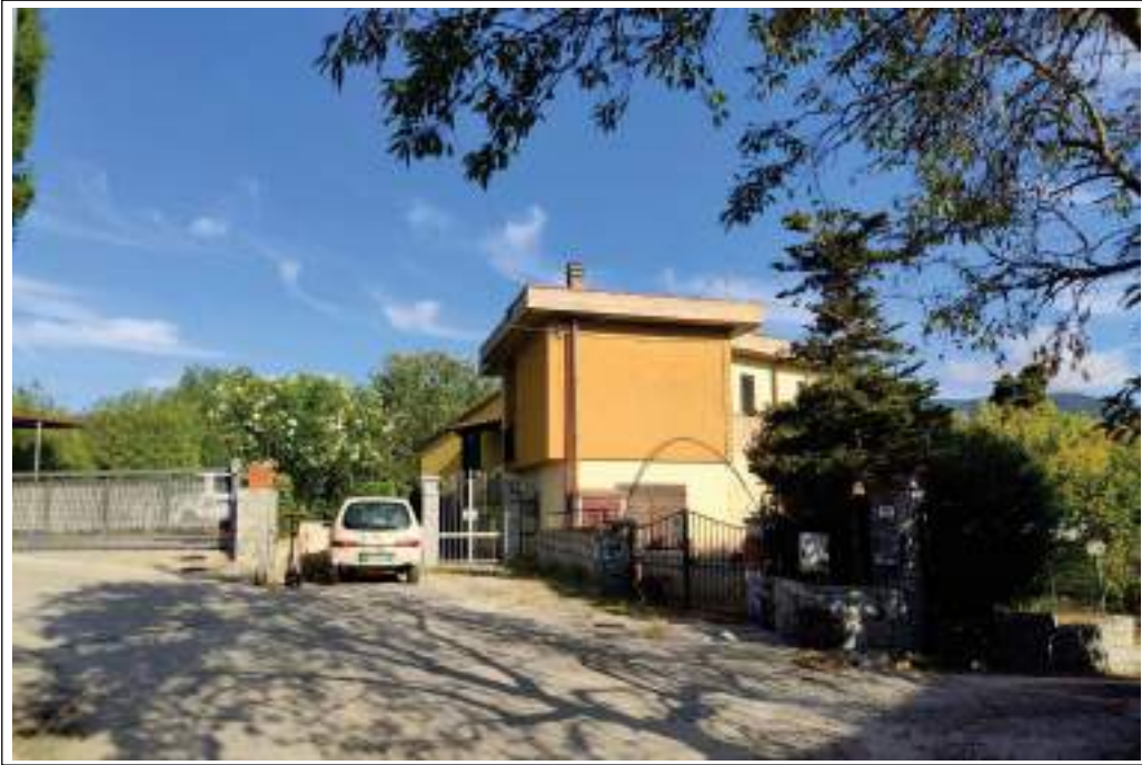
Descrizione: Foto di prospetto, da strada
