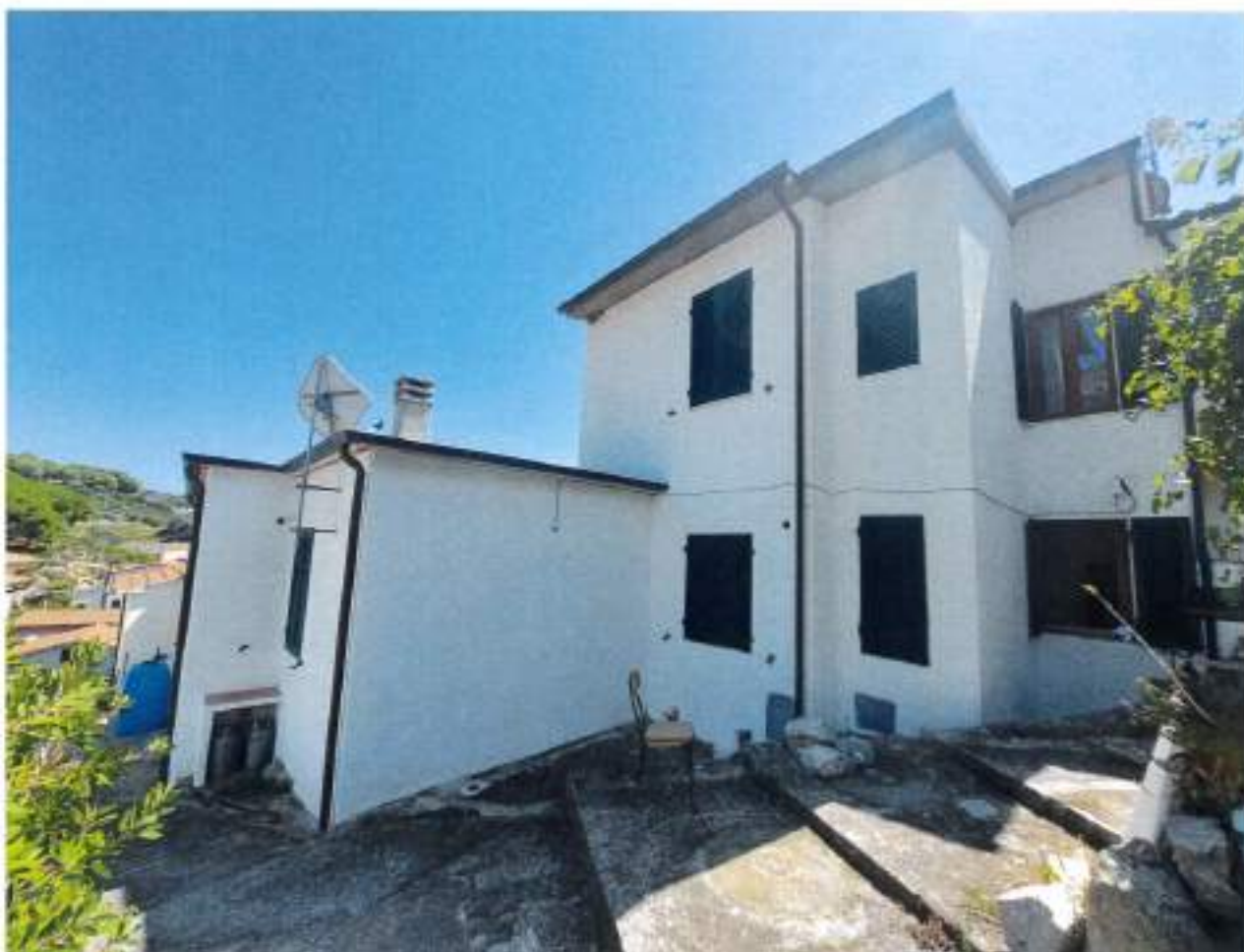
Descrizione: Prospetto Ovest
