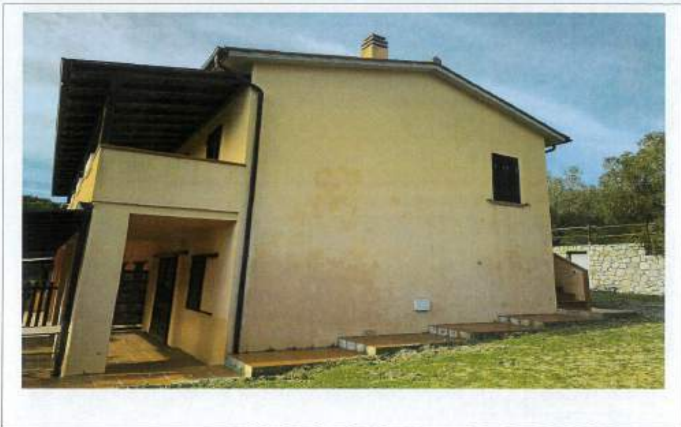
Descrizione: Vista lato est
