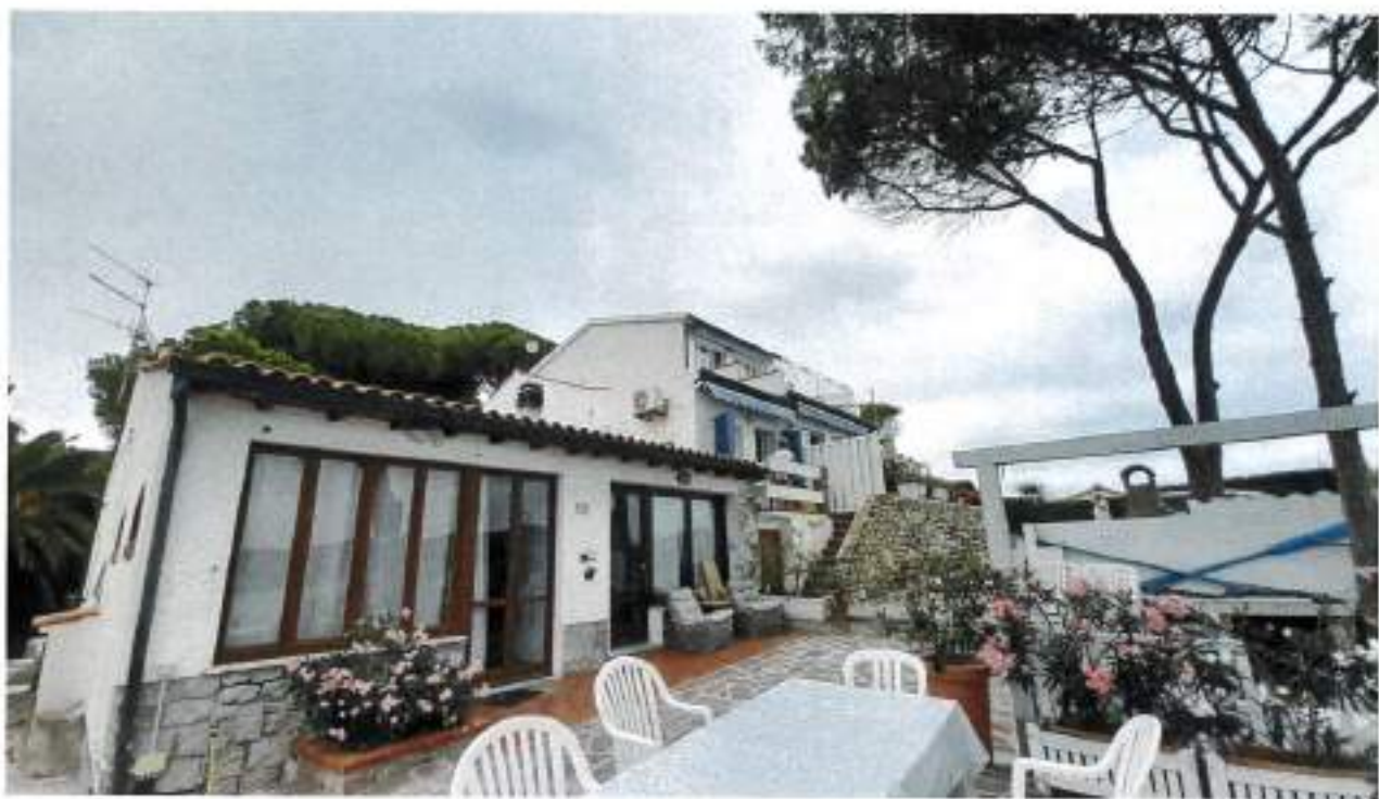
Descrizione: Prospetto lato Ovest
