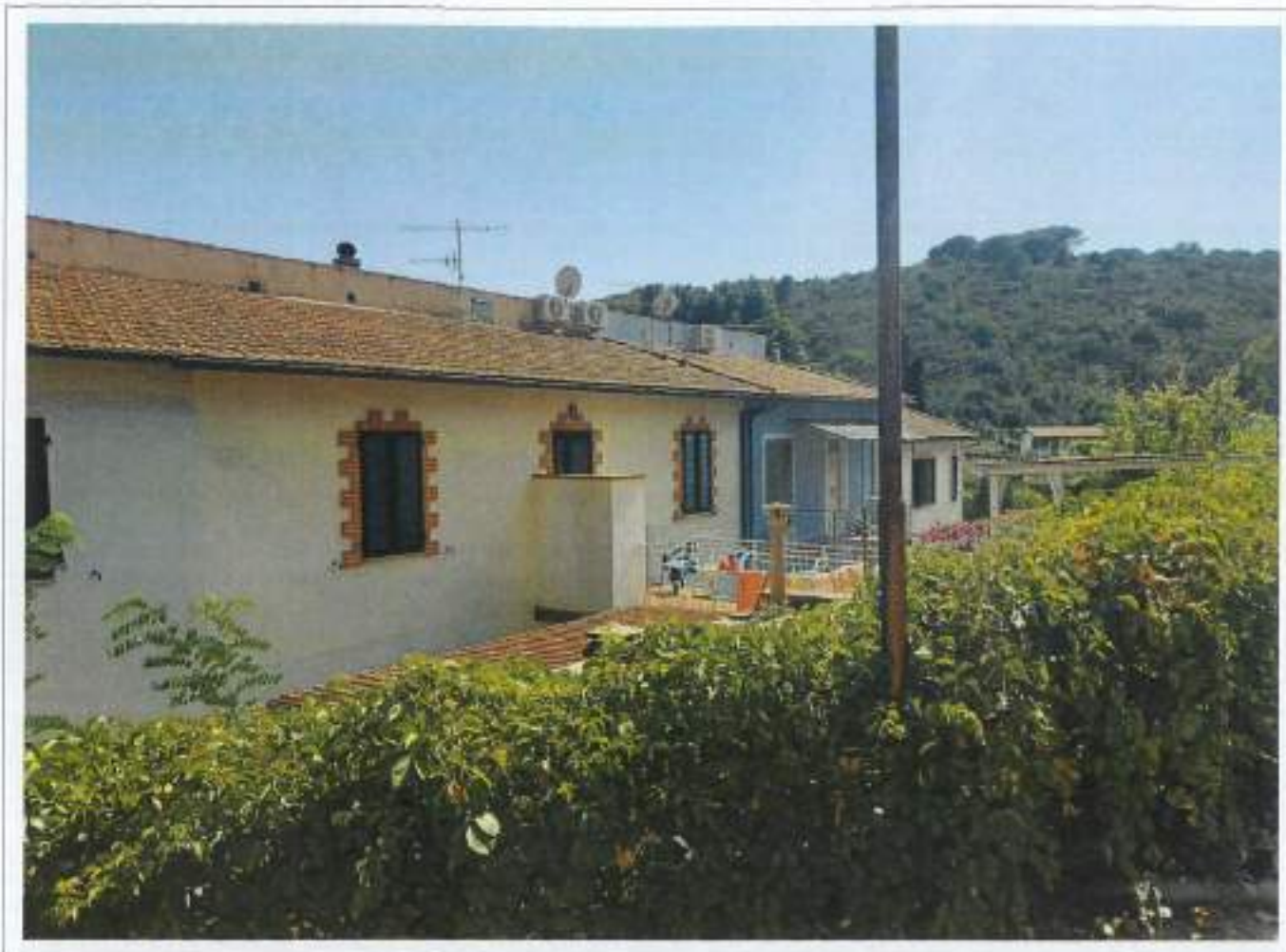
Descrizione: - Vista lato nord – panoramica corpo di fabbrica
