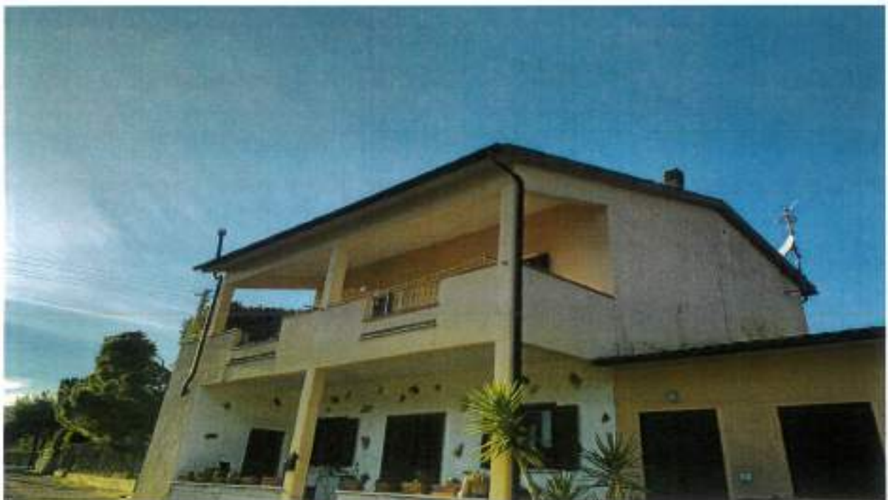
Descrizione: - Vista lato sud
