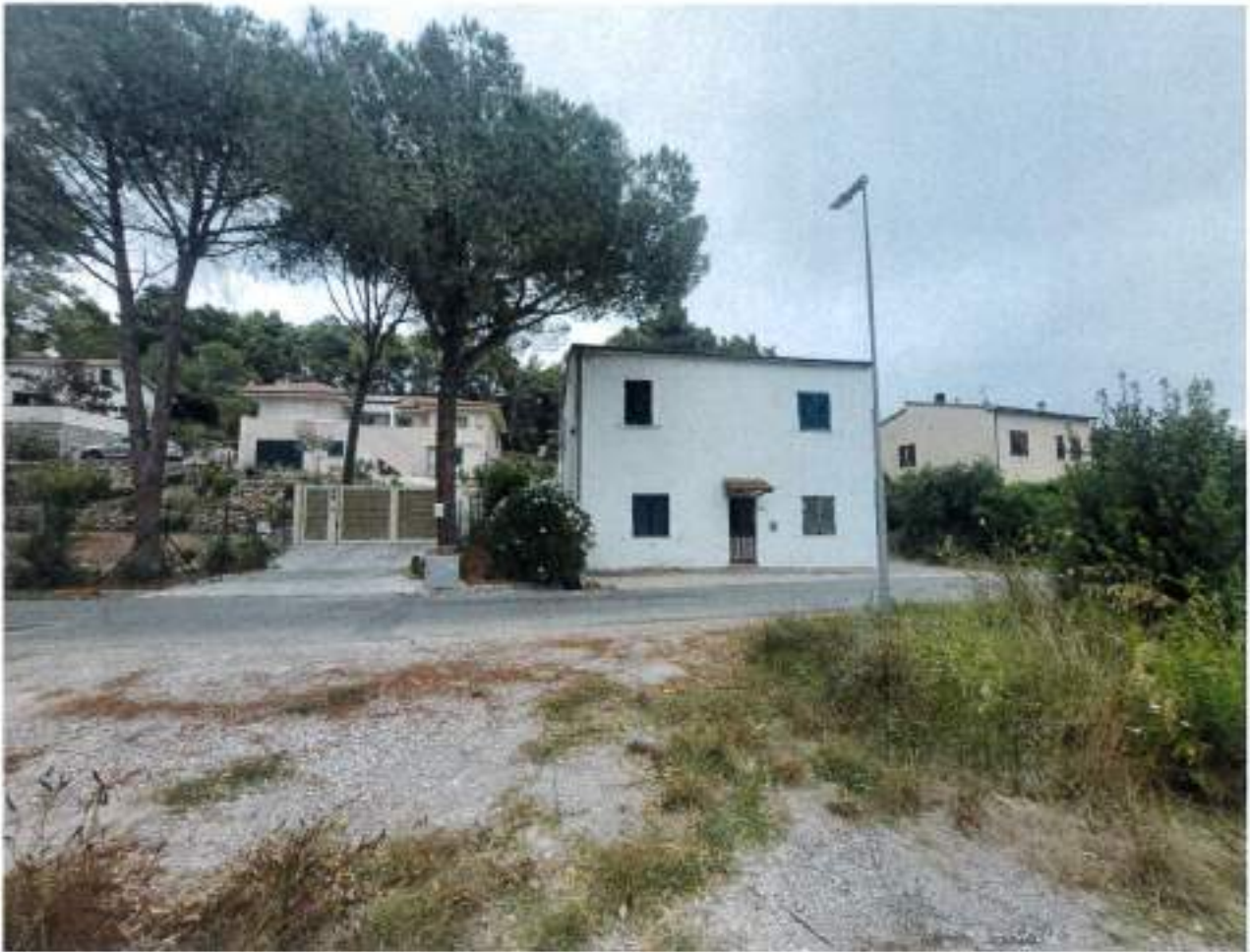
Descrizione: Vista panoramica prospetto principale
