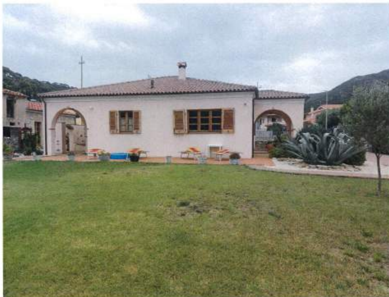
Descrizione: Prospetto lato Ovest.
