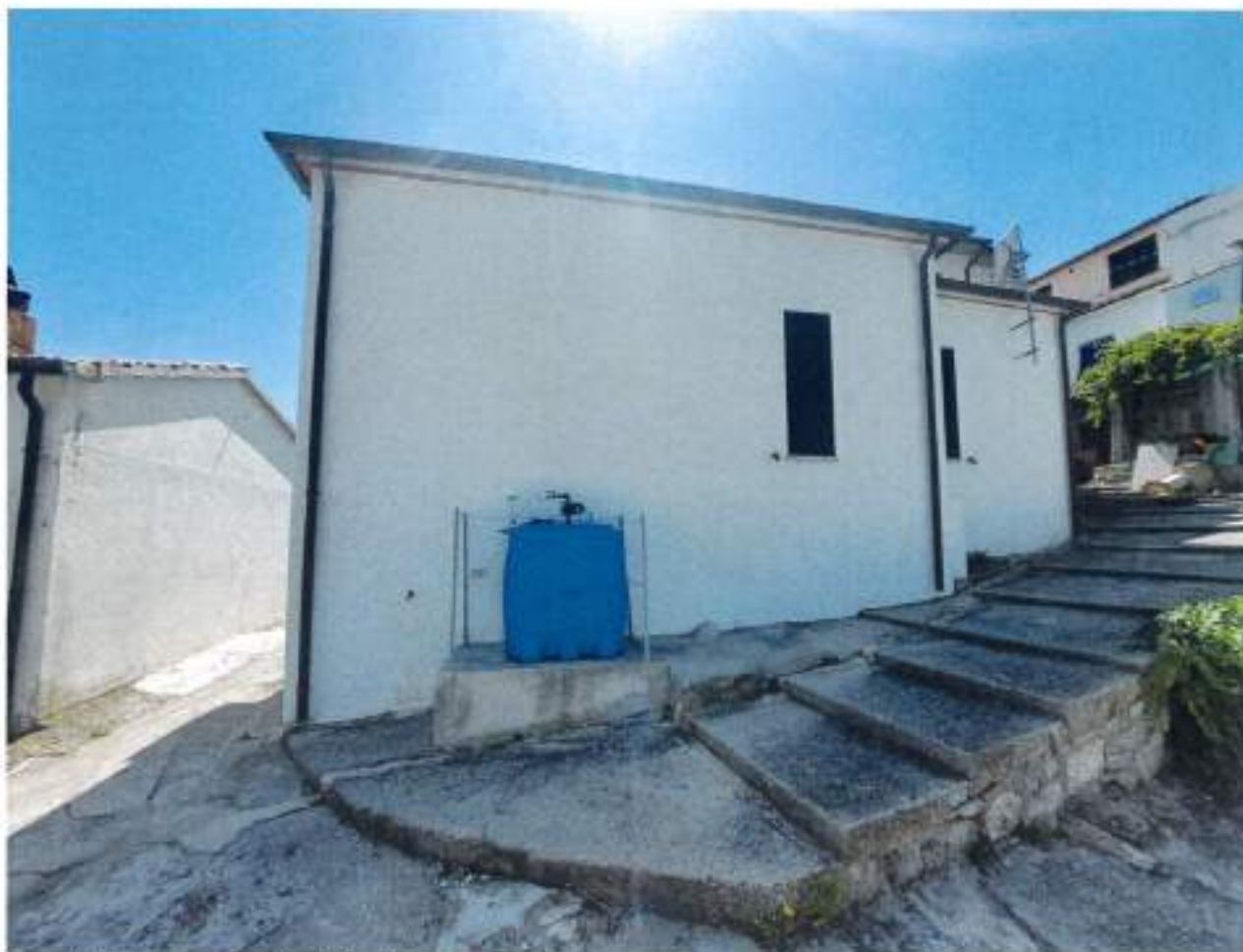
Descrizione: prospetto lato Nord.
