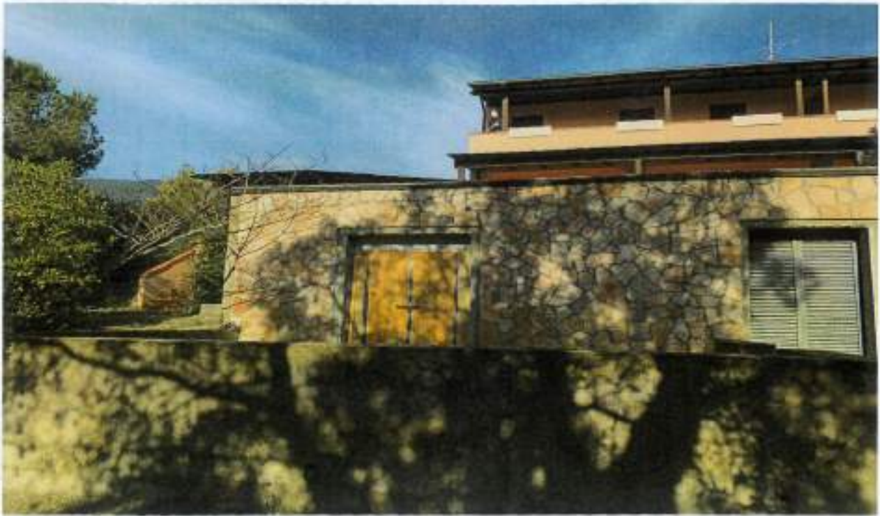
Descrizione: - Vista lato sud -
