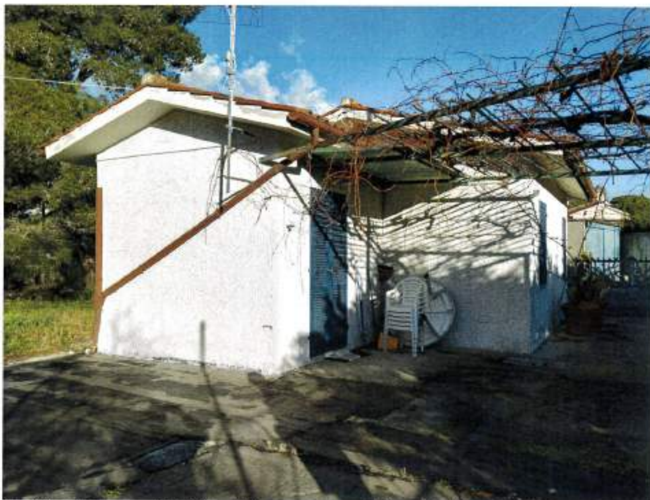
Descrizione: Vista prospetti lati Sud ed Est, non sono presenti elementi architettonici di valore
