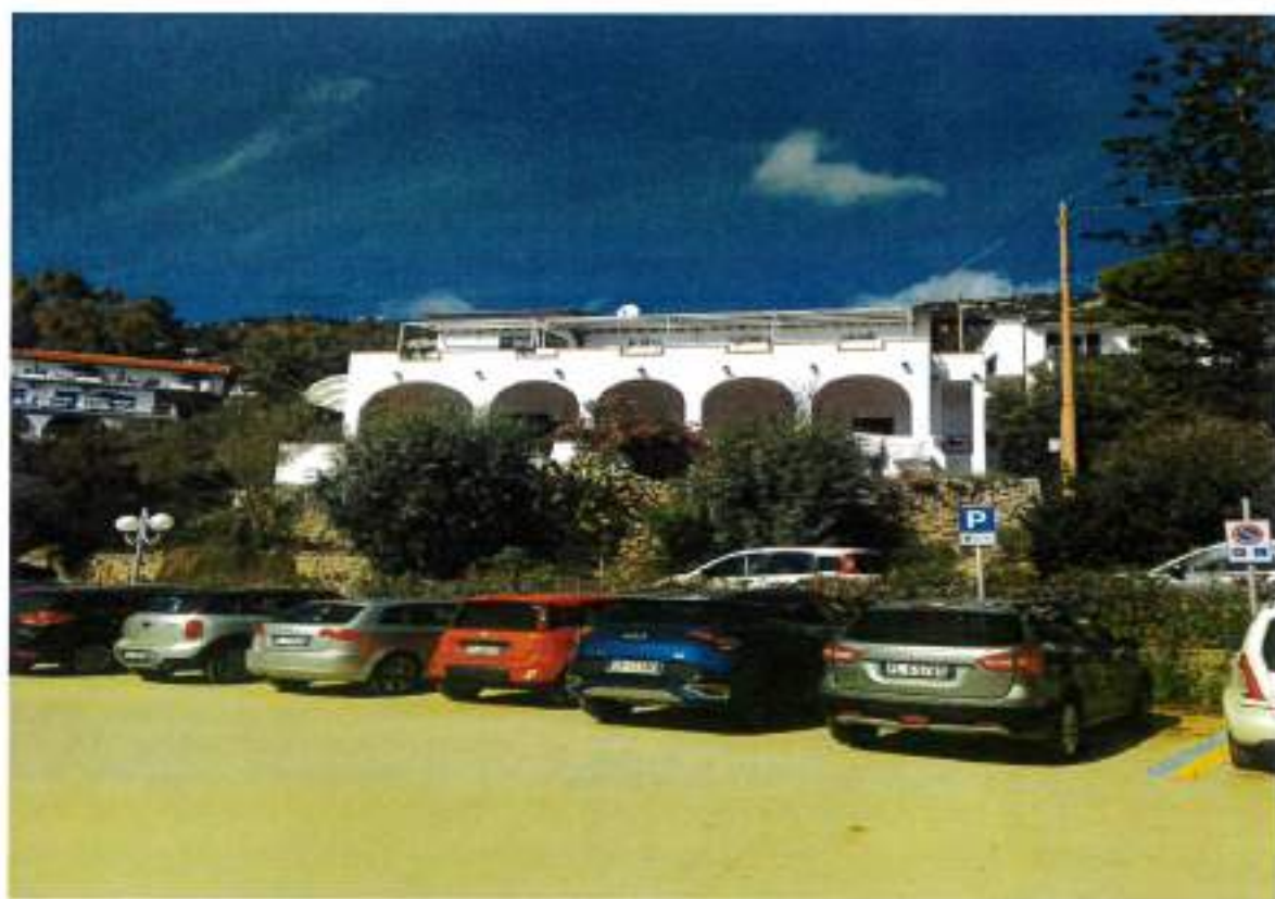
Descrizione: - Vista lato sud -
