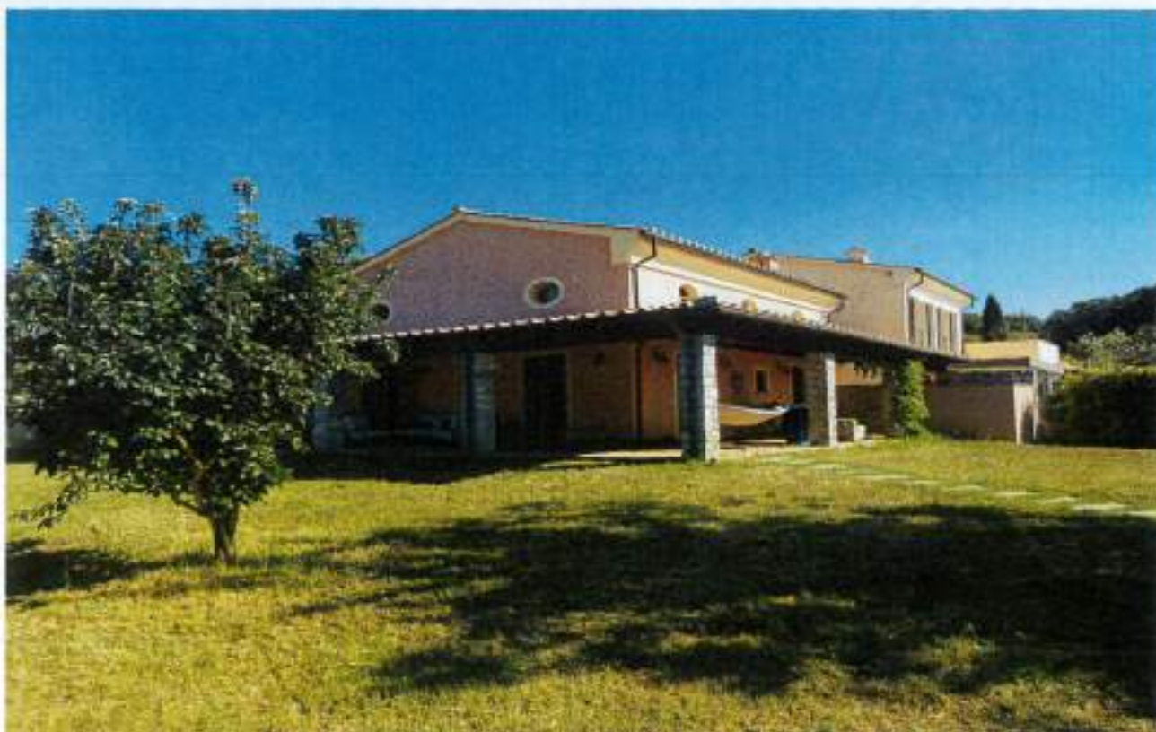
Descrizione: - Vista lato SUD - OVEST
