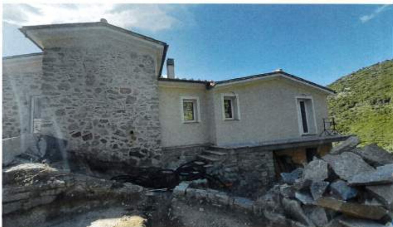
Descrizione: Prospetto Nord, è evidente la porzione di fabbricato con paramento murario a facciavista
