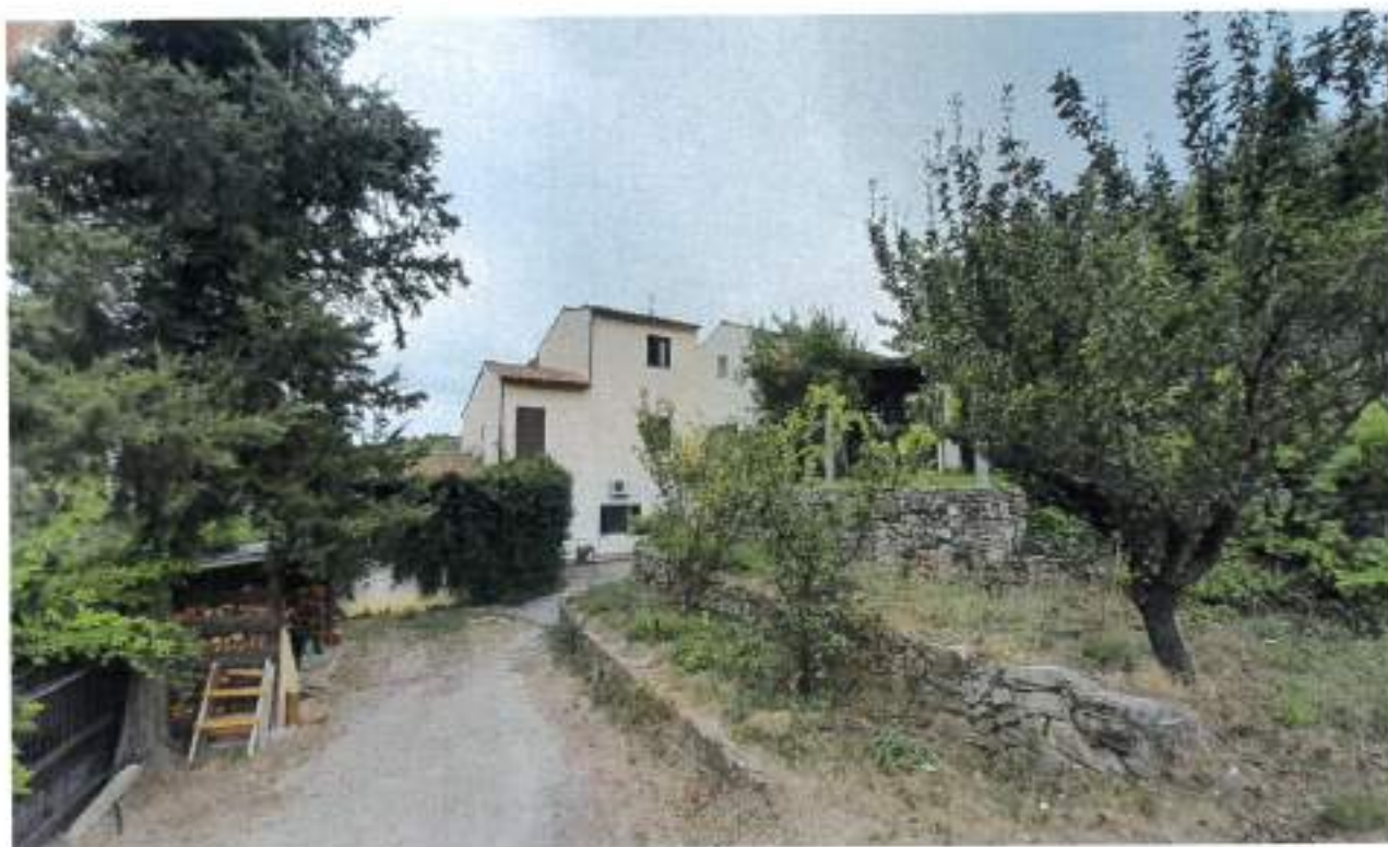
Descrizione: Vista panoramica prospetto Ovest.
