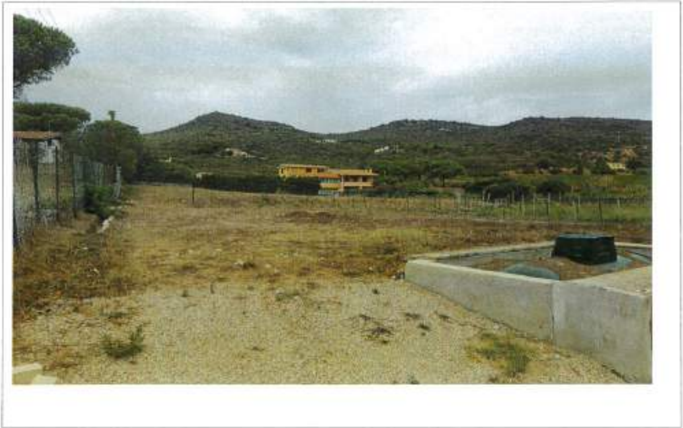
Descrizione: - Vista lato sud - corte
