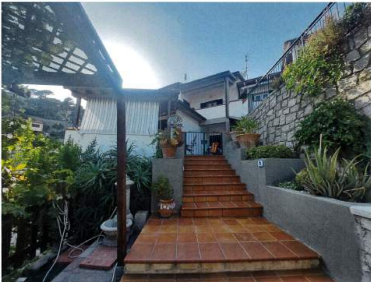
Descrizione: Prospetto Est, è evidente la struttura in c.a. di recente realizzazione
