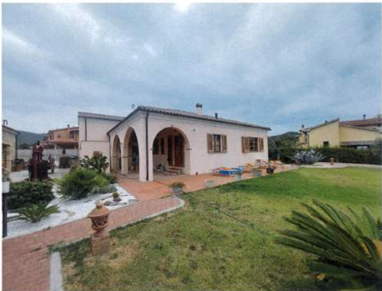
Descrizione: Vista panoramica prospetti lato Nord ed Ovest.
