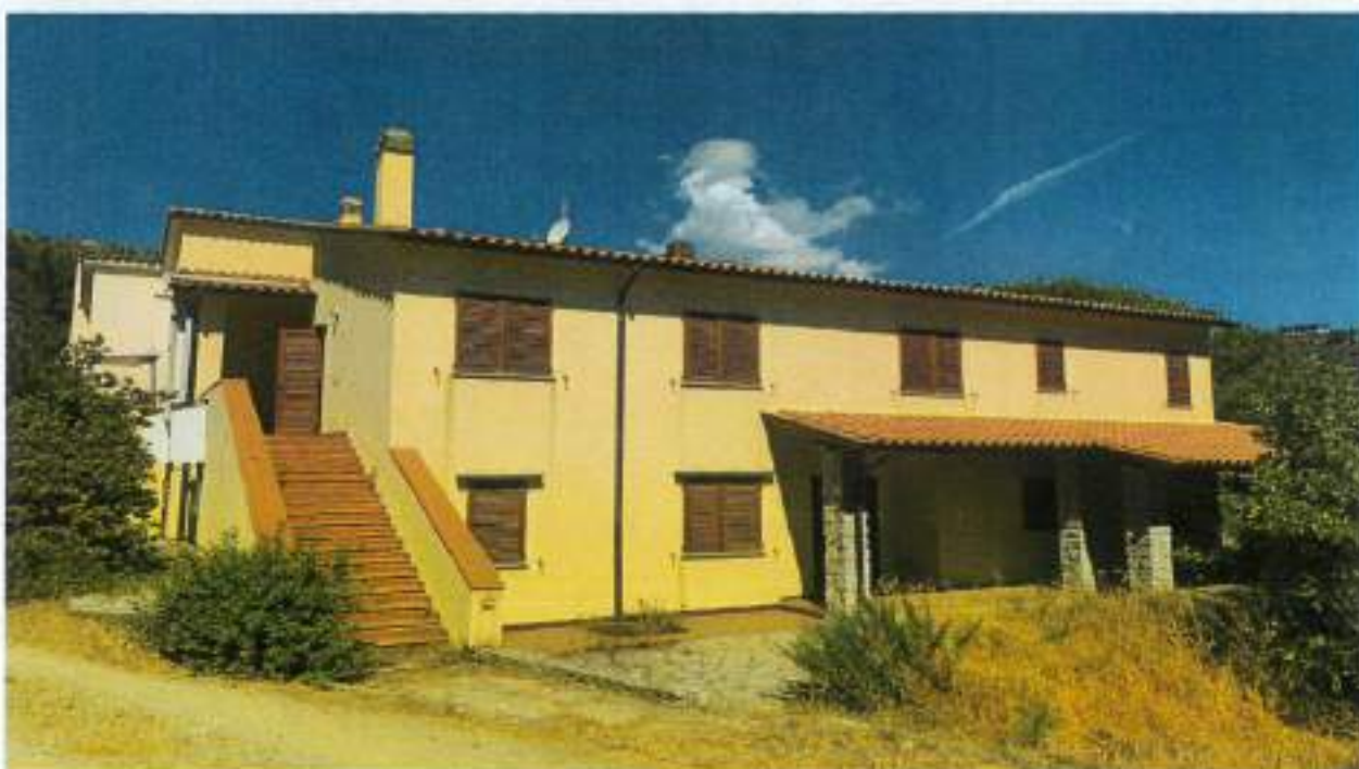
Descrizione: - Vista lato EST
