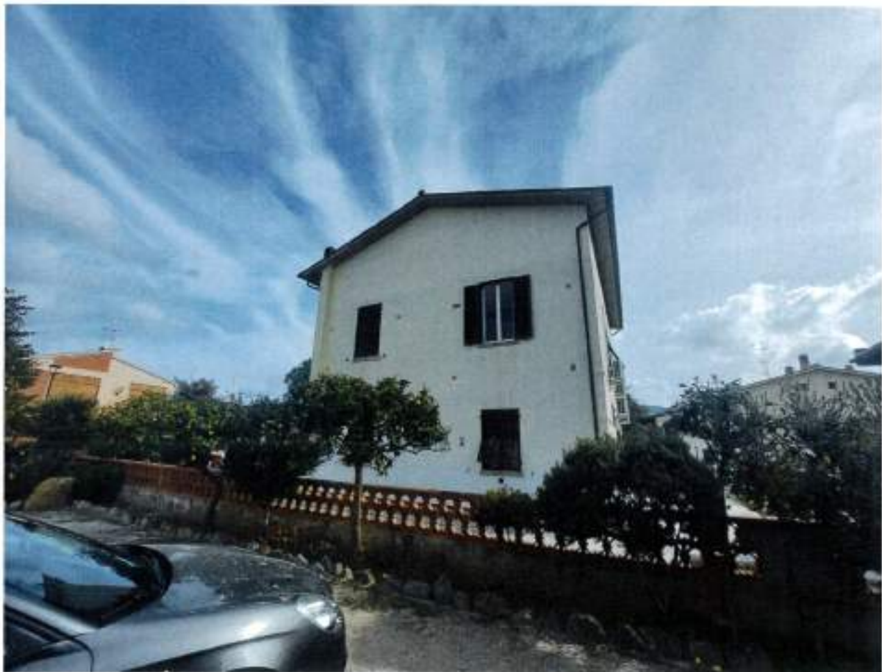
Descrizione: Prospetto Ovest.
