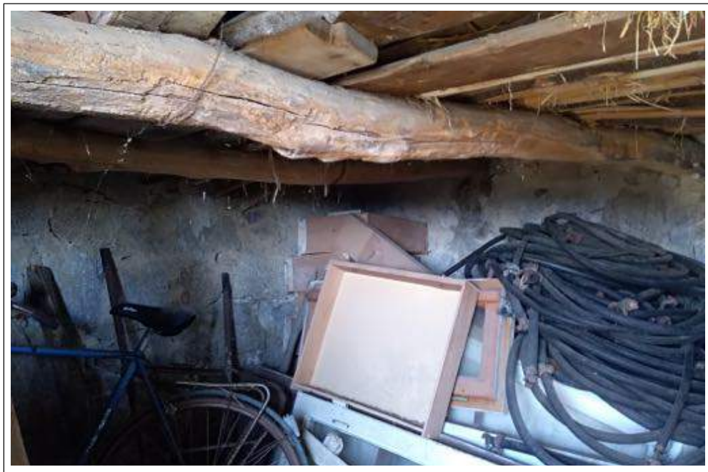
Descrizione: punto di ripresa interno;
