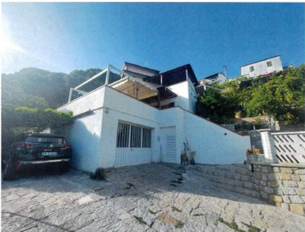
Descrizione: Prospetto lato Sud-Est
