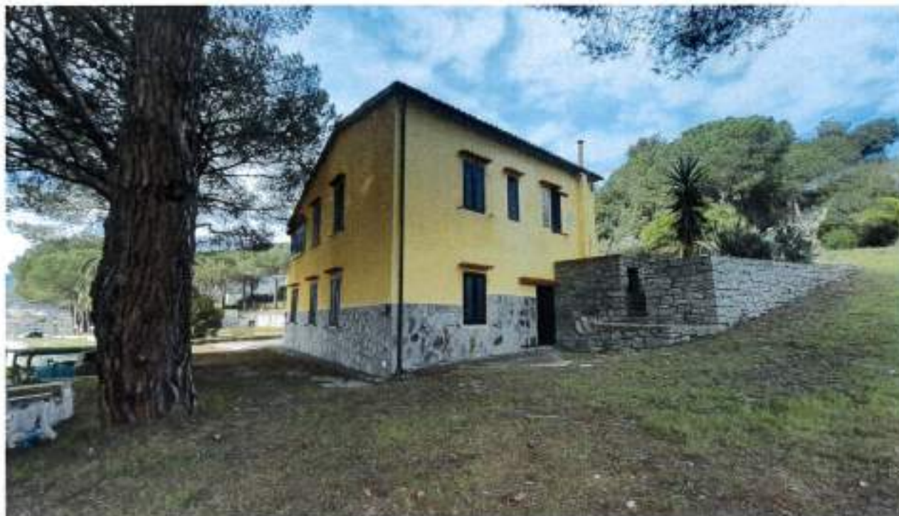
Descrizione: Vista prospetti Sud ed Est, non sono presenti particolari architettonici di rilevanza storica
