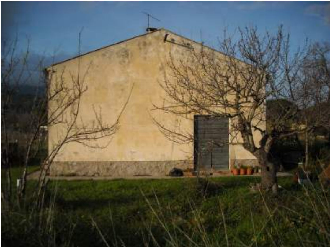
Prospetto laterale destro
