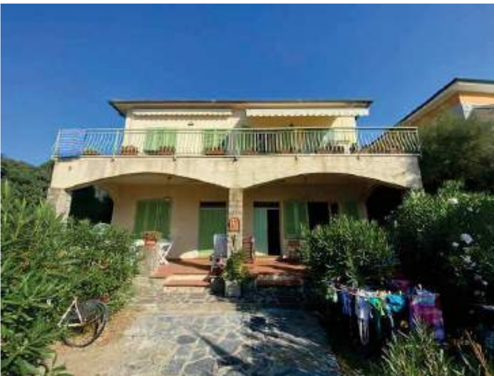
Descrizione: prospetto principale (Sud)
