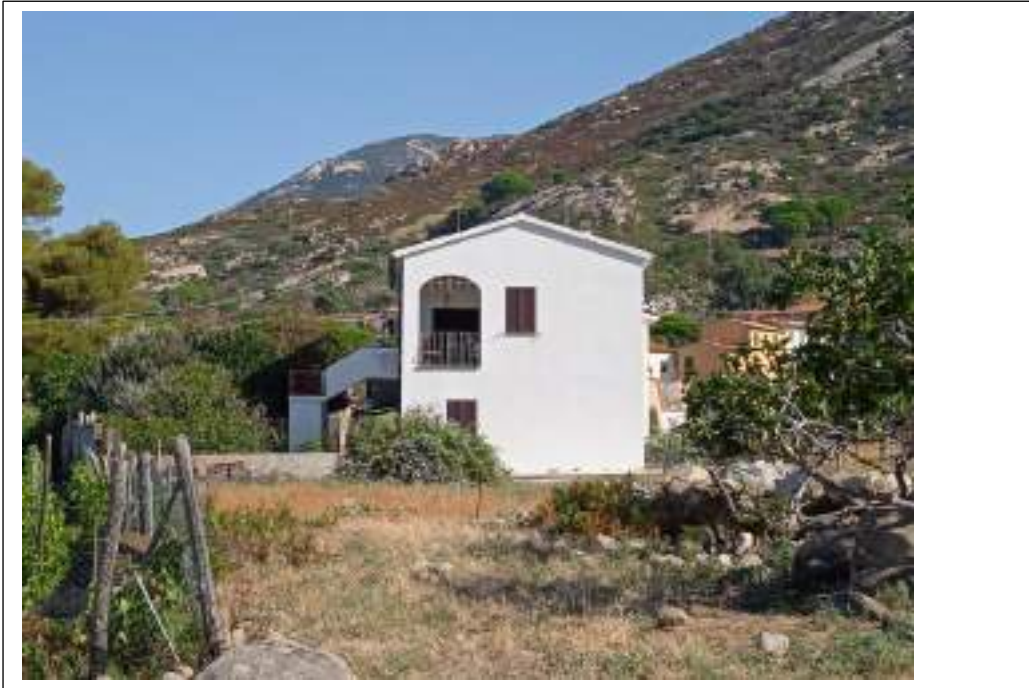
Descrizione: FOTO 2 Prospetto lato sud
