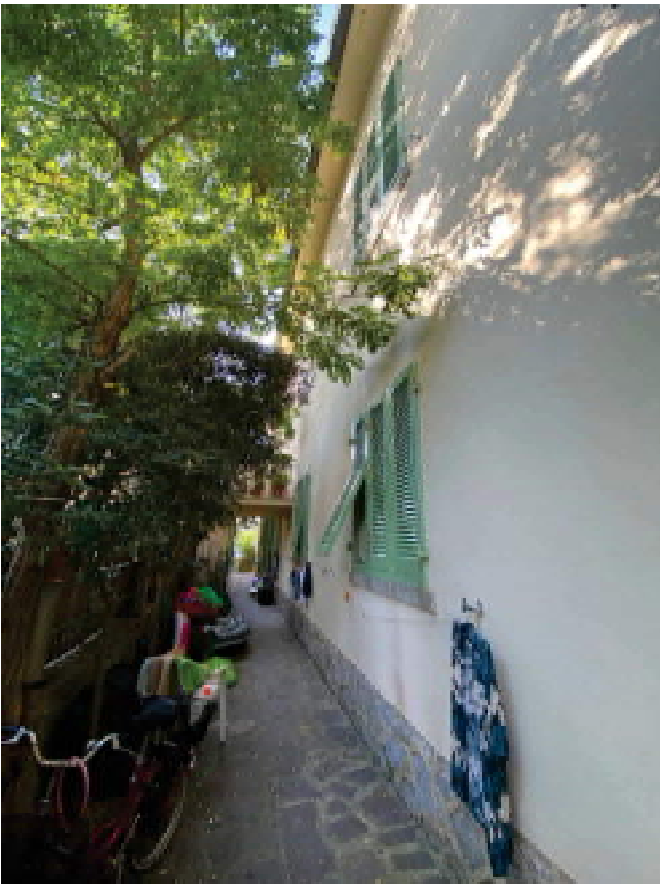
Descrizione: prospetto Ovest
