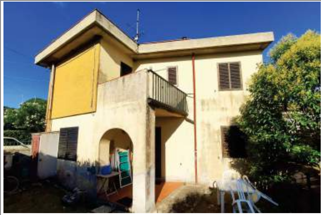
Descrizione: Foto di prospetto verso l'ingresso dell'abitazione, dal giardino interno
