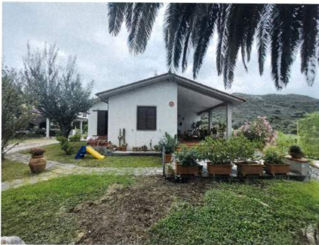
Descrizione: Prospetto Ovest
