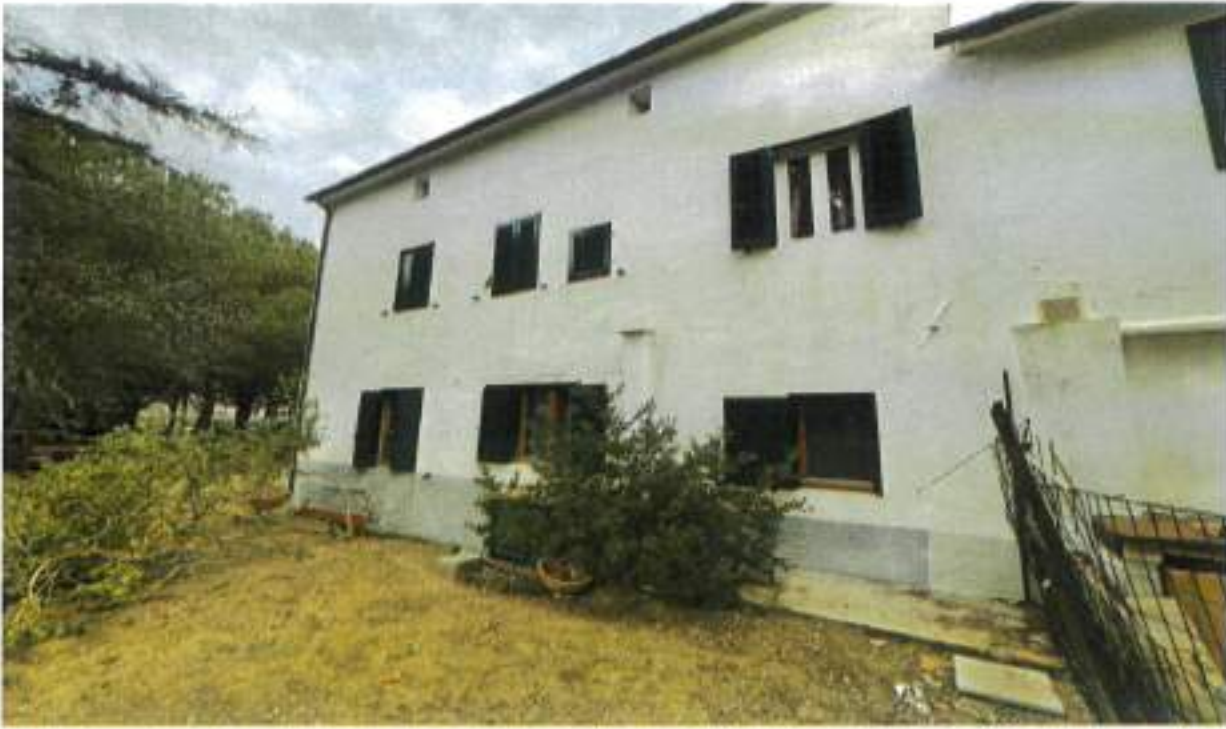
Descrizione: Vista lato SUD
