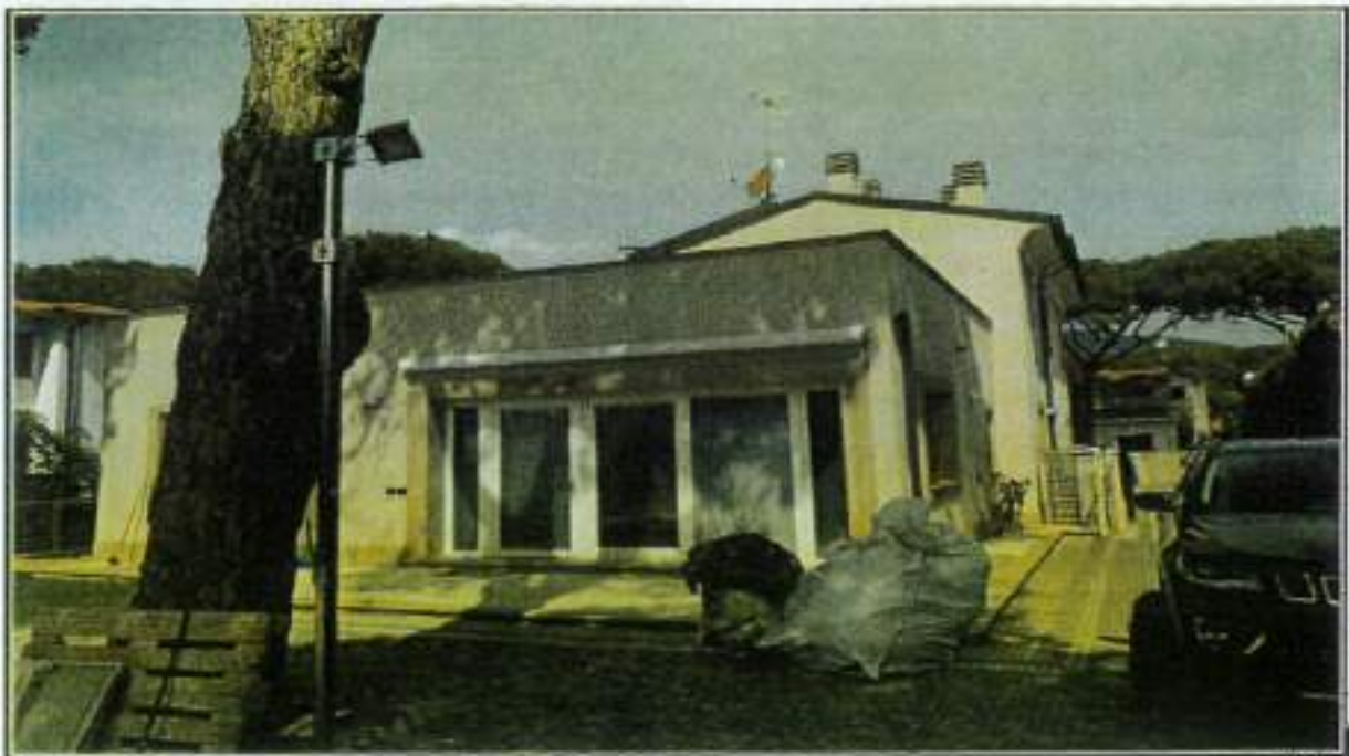
Descrizione: - Vista lato SUD
