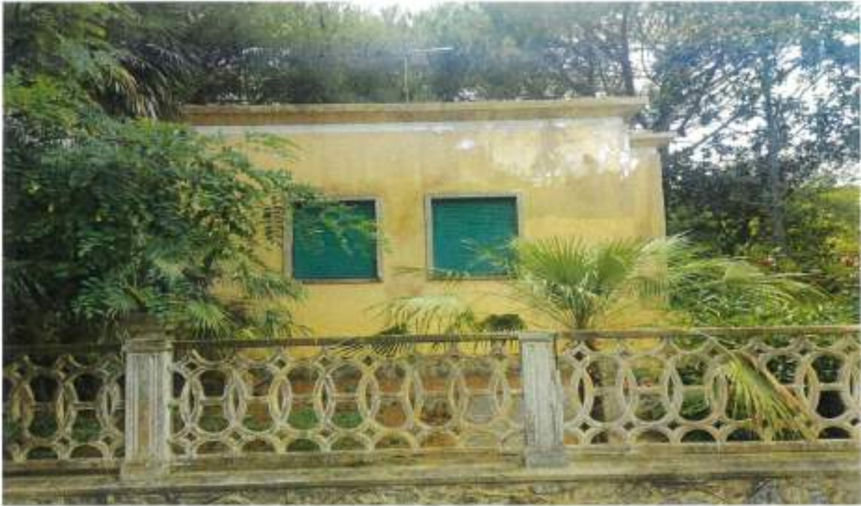
Descrizione: Vista lato EST
