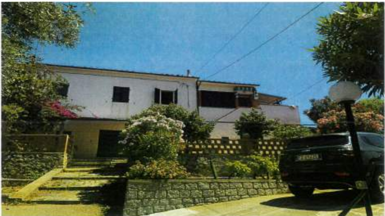
Descrizione: - Vista lato sud
