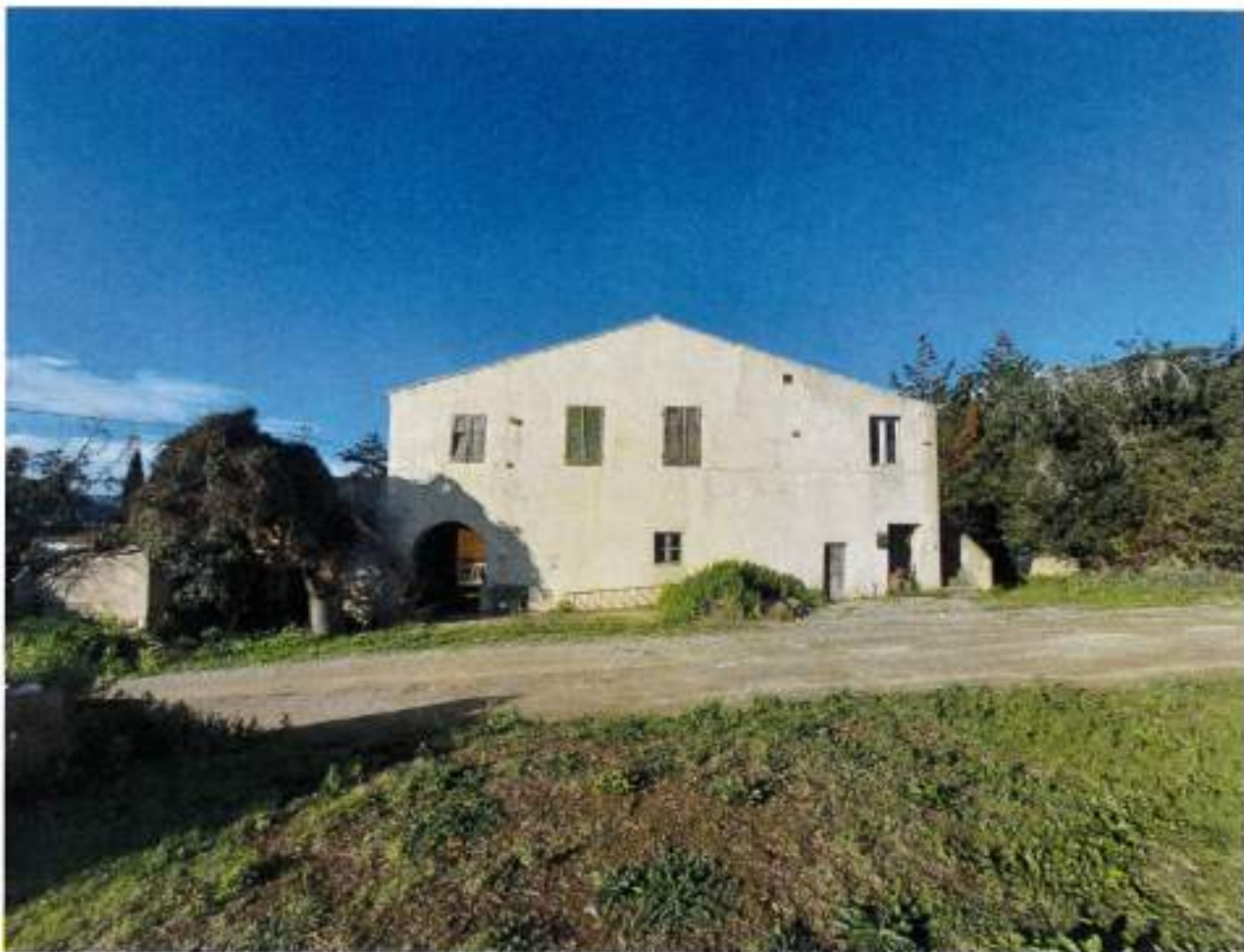
Descrizione: Prospetto Est, presenza di aperture incongrue dovute a modifiche effettuate negli anni
