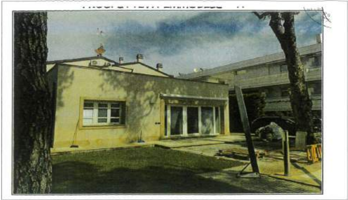
Descrizione: Vista lato SUD / 2
