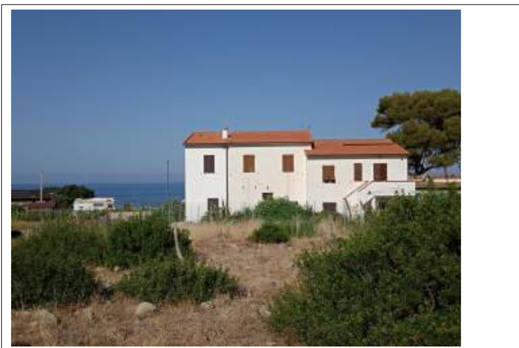
Descrizione: FOTO 3 Prospetto lato est
