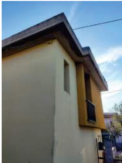
Descrizione: Foto di dettaglio della grondaia
